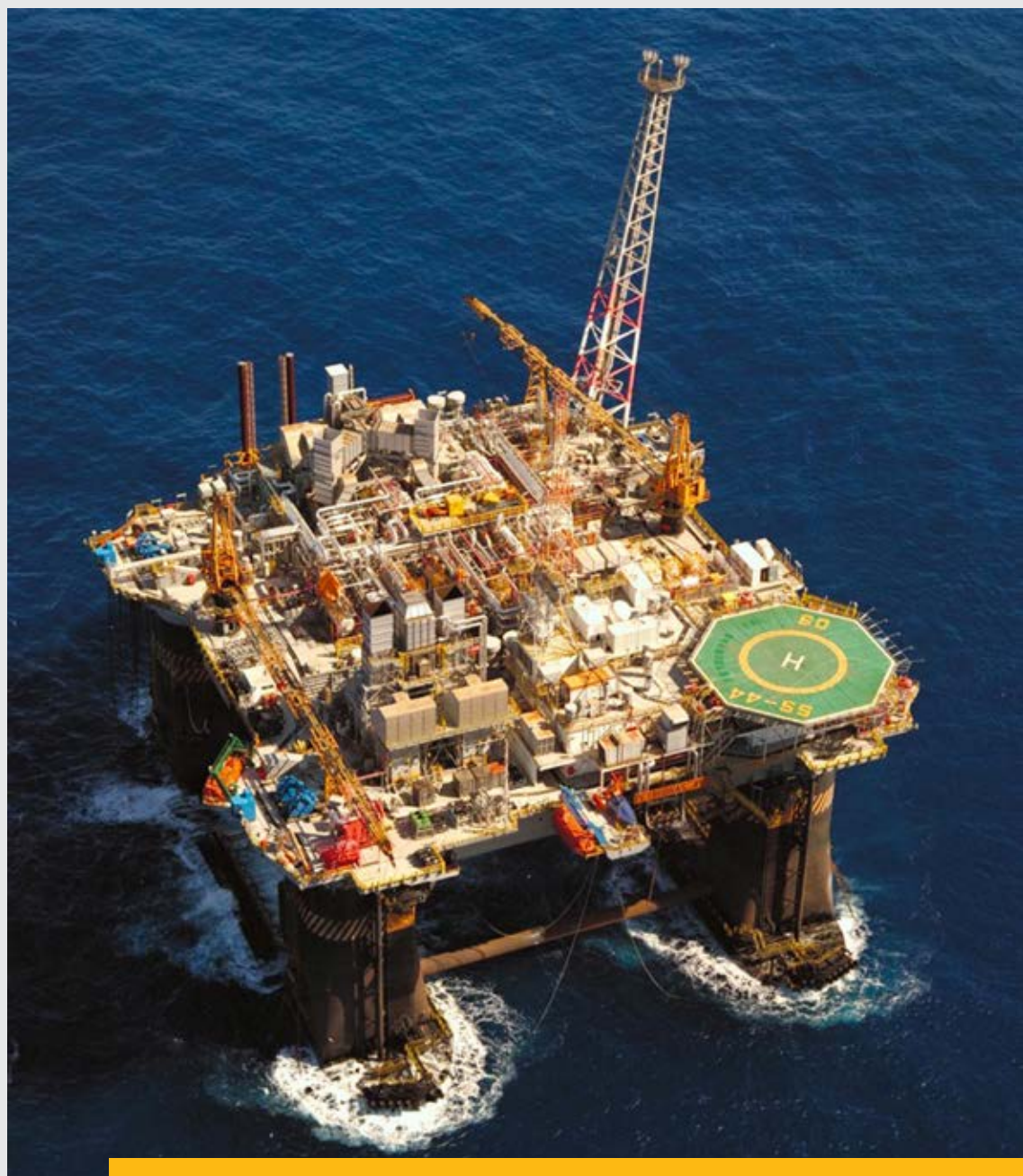
Vista aérea da Plataforma Petrobrás XVIII, Campo de Marlim, estado do Rio de Janeiro. Fonte: Arquivo IPT. Crédito: Petrobrás.
